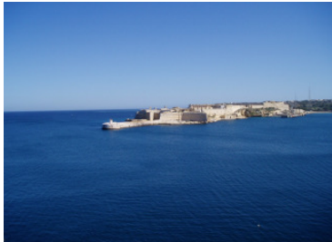
Befestigungsanlagen der Hafeneinfahrt
